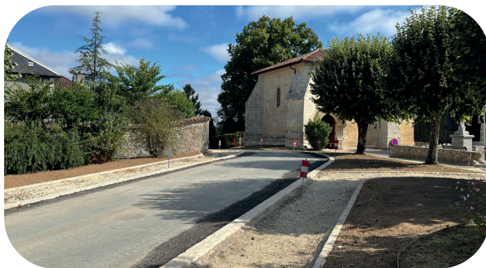
Réaménagement du bourg
