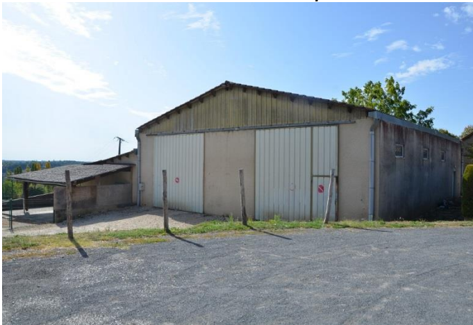
Atur (démolition prévue fin octobre 2019)
